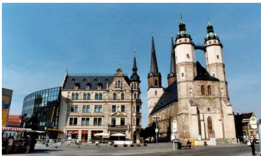
Veduta esterna della Marktkirche
