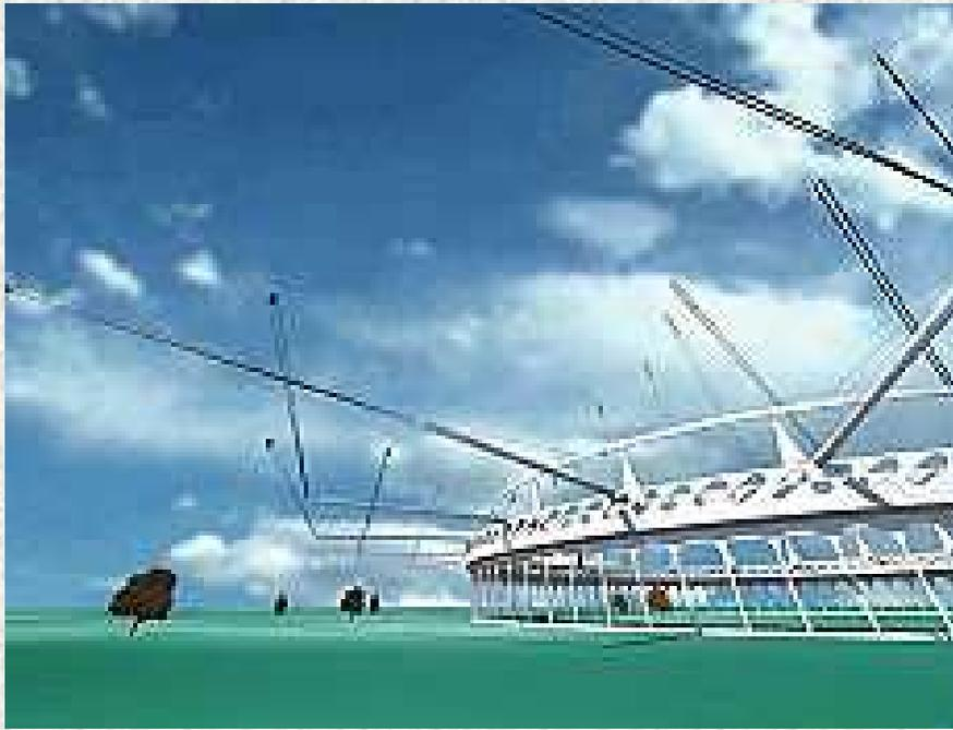
A 80 metri di altitudine il vento tira, in media, a 4,6 m/s, un po' più di 16 km/h. E' un primo problema. Sotto i 4 m/s, infatti, le turbine normali, vengono spente, perché diventano antieconomiche. A 800 metri di altitudine, dove sarebbero collocati gli aquiloni, il vento soffia, in media, a 7,2m/s. La velocità ottimale. E un parametro cruciale, perché, come spiegano i manuali di fisica, l'energia che si può ottenere dal vento aumenta in modo esponenziale con la sua velocità.
