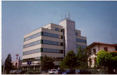
Sito GSM su costruzione civile
